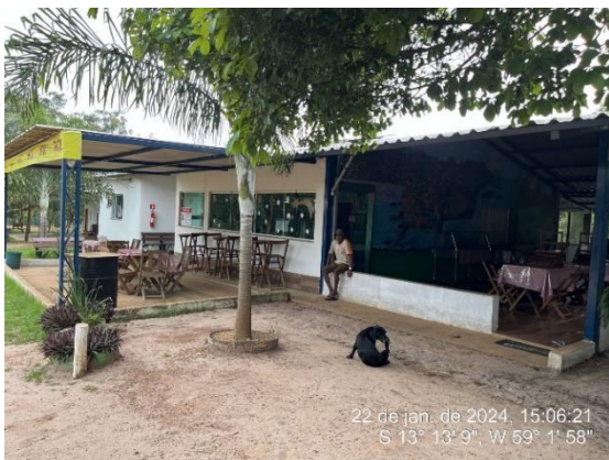
Foto 3 – Estrutura do restaurante.
