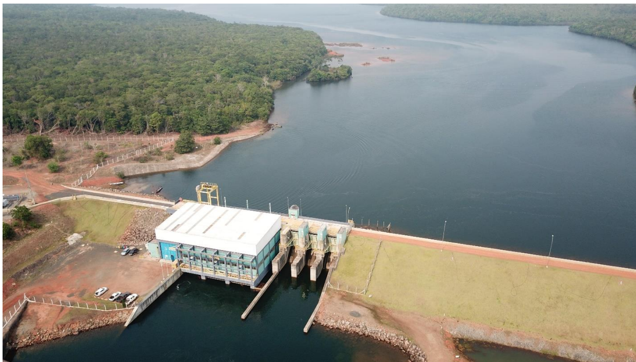
Figura 39 – Casa de Força PCH Sapezal
