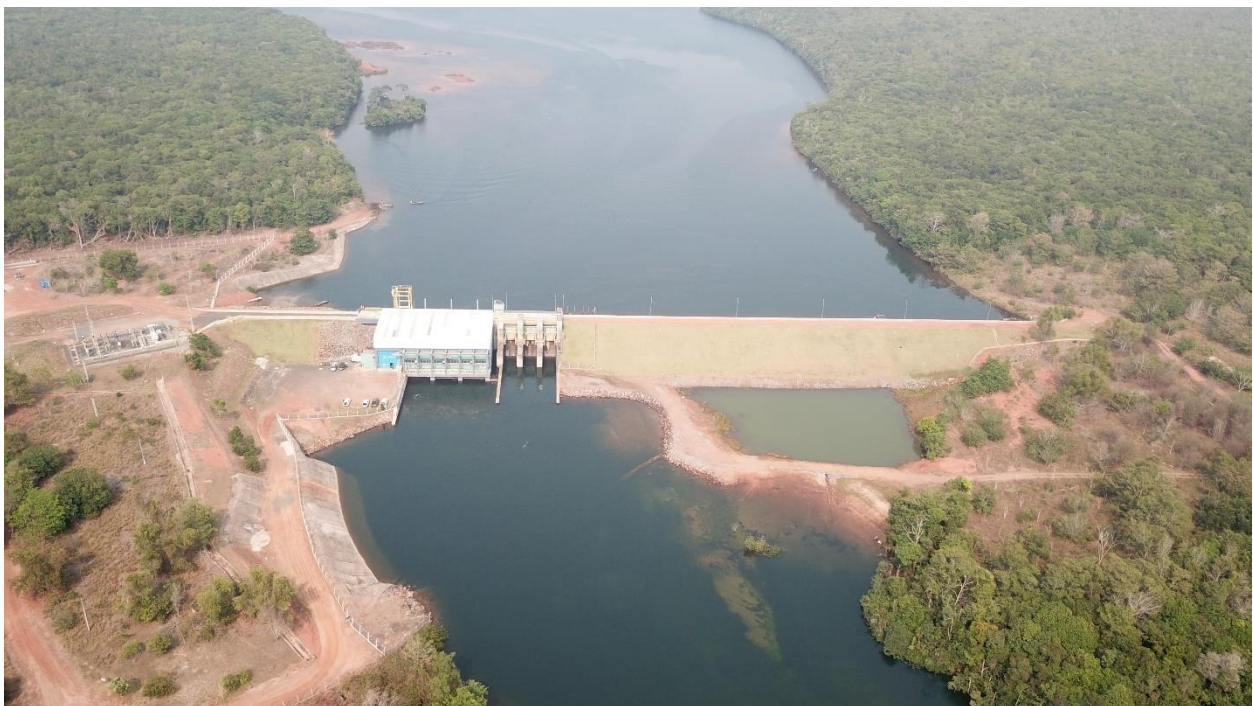
Figura 19 – Vista Geral do Barramento
