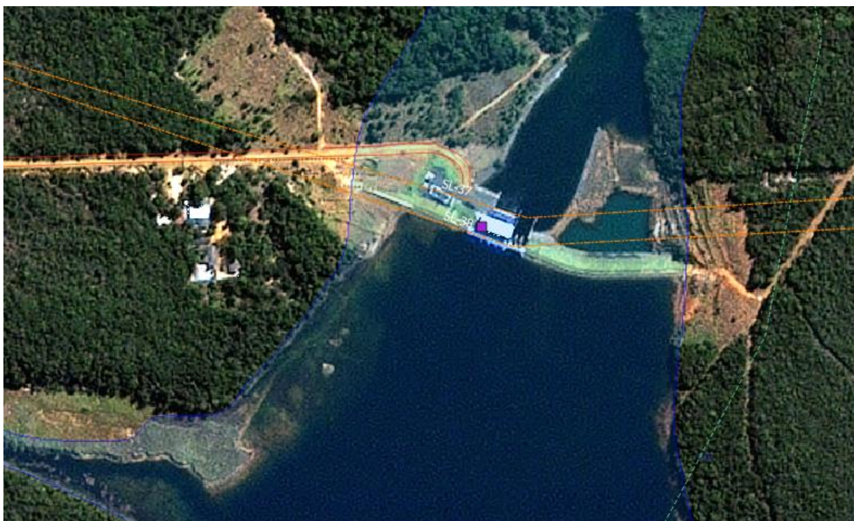
Figura 46 – Localização Barragem/Casa de Força PCH Rondon – SL-38/37
