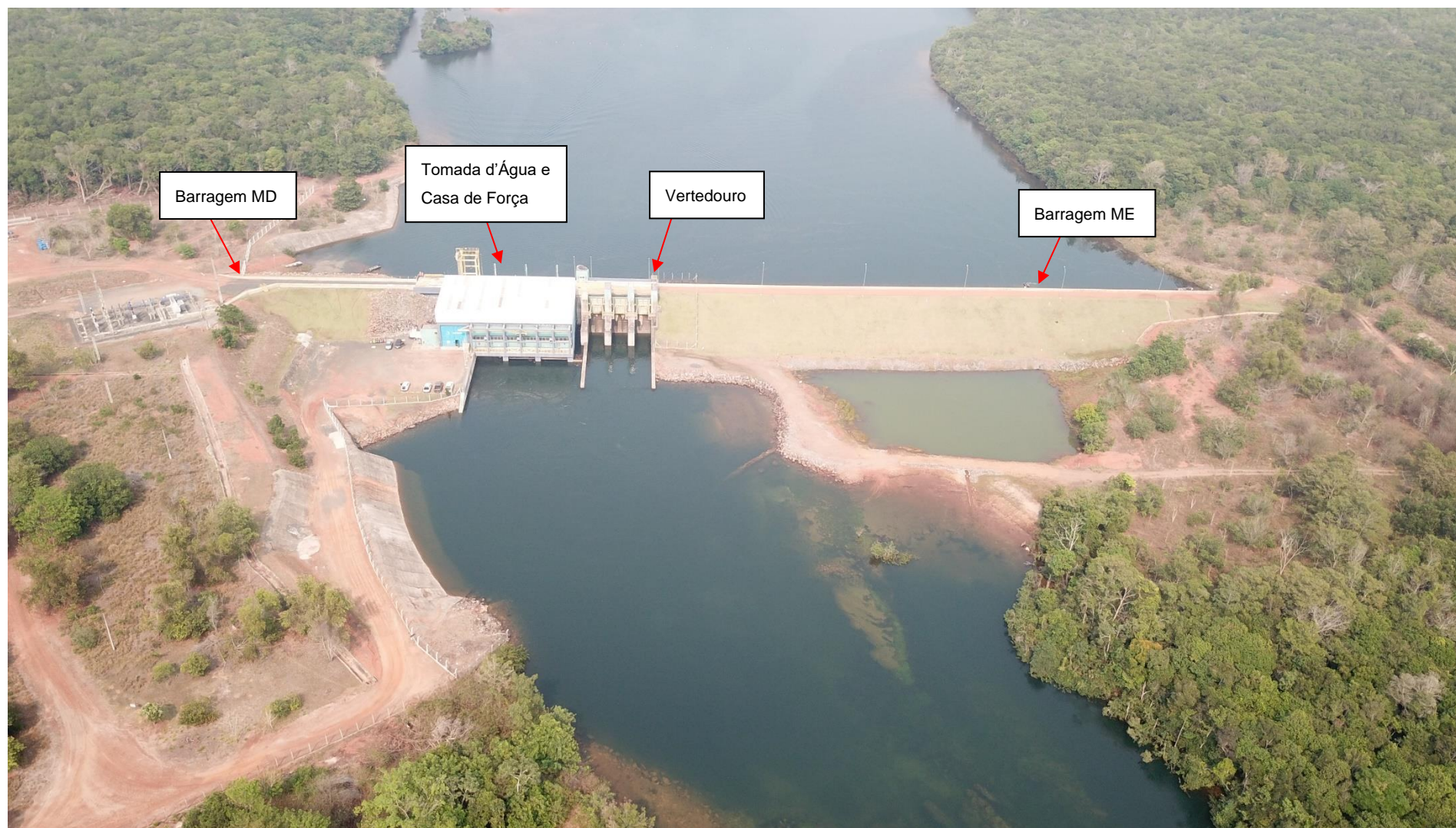
Figura 1 – Foto das estruturas civis – PCH Sapezal
