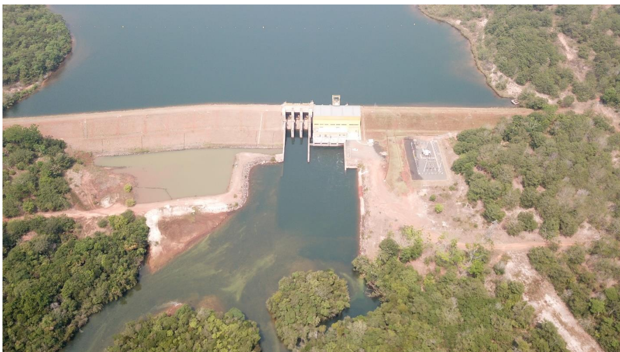
Figura 27 – PCH Ilha Comprida
