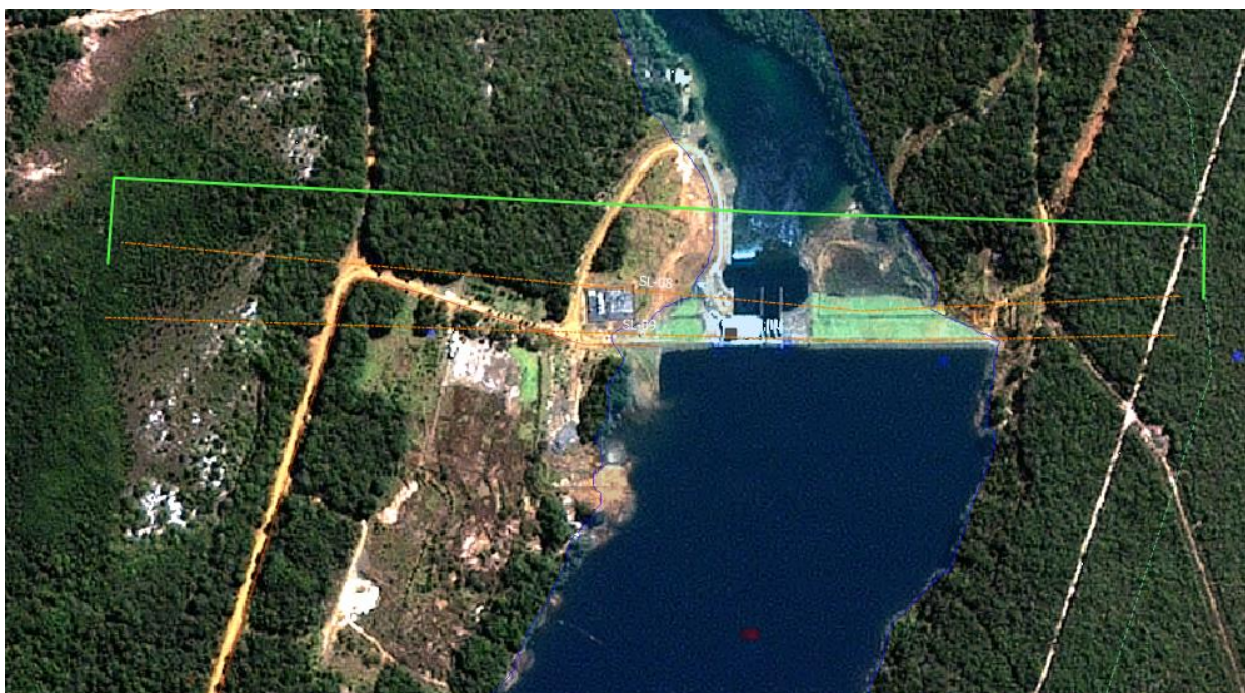
Figura 47 – Localização Barragem/Casa de Força PCH Telegráfica – SL-9
