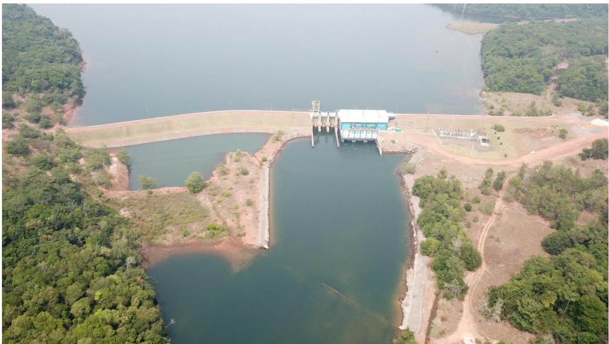
Figura 20 – Vista Geral do Barramento
