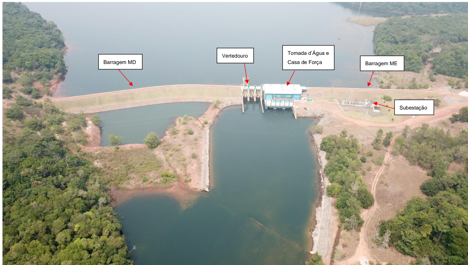
Figura 1 – Foto das estruturas civis – PCH Rondon
