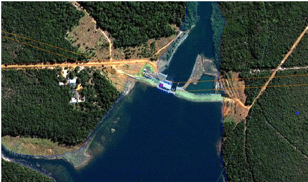
Figura 34 – Localização Barragem/Casa de Força PCH Rondon – SL-38
