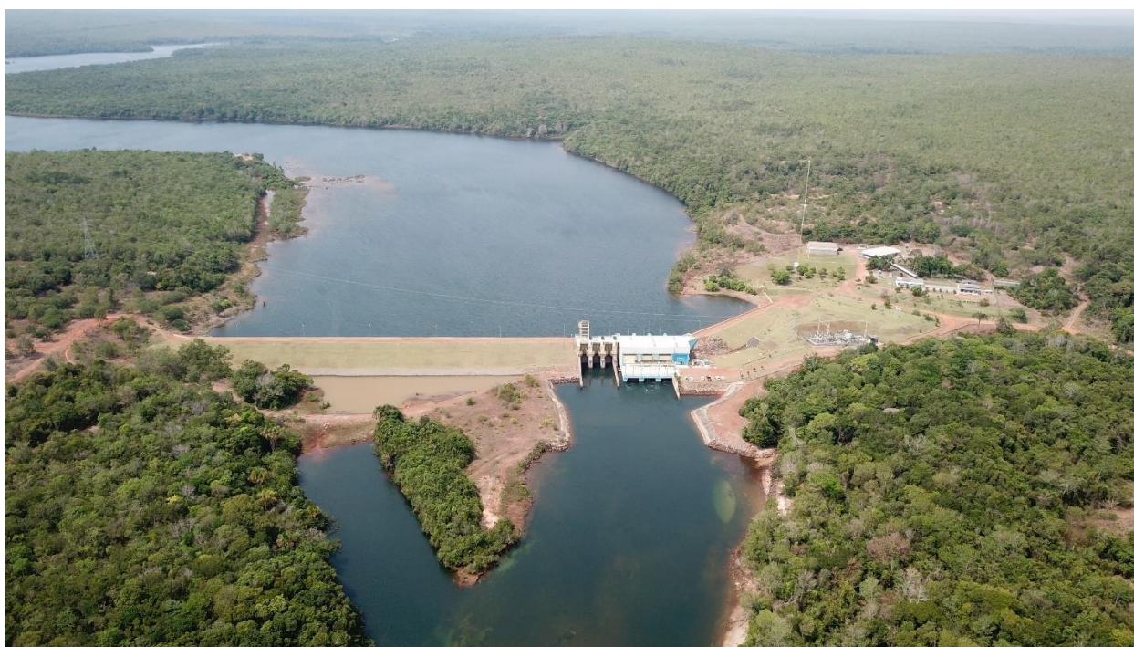
Figura 19 – Vista Geral do Barramento
