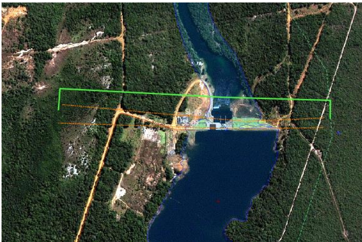
Figura 35 – Localização Barragem/Casa de Força PCH Telegráfica – SL-9
